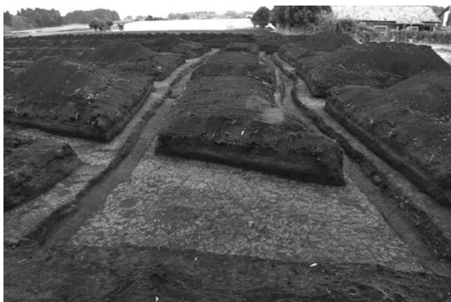
▲道路遺構掘削完了状況(北→南)
